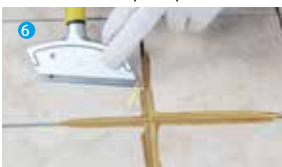
Loại bỏ vữa thừa bằng dao cạo sau khi đã chữa cứng.
