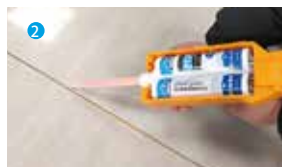
Gắn ống trộn vào ống cartridge và lắp vào súng bơm keo
