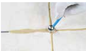
Chọn quả bi thép phù hợp để ấn với hiệu quả đẹp mắt tùy theo kích thước của khe nối.
