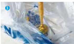
Ấn súng bơm keo và loại bỏ 40 cm đầu tiên
